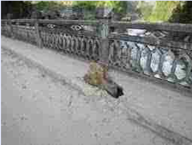
歩道の落石被害
